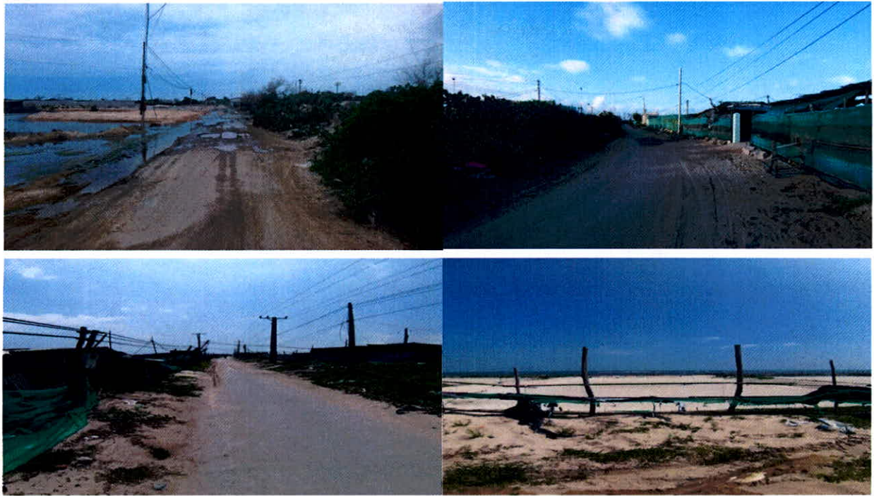
Hình 4: Một số hình ảnh hiện trạng của Dự án thành phần Nâng cấp mở rộng tuyến đường quốc phòng cũ (701), xã Phước Dinh, huyện Thuận Nam, tỉnh Ninh Thuận
